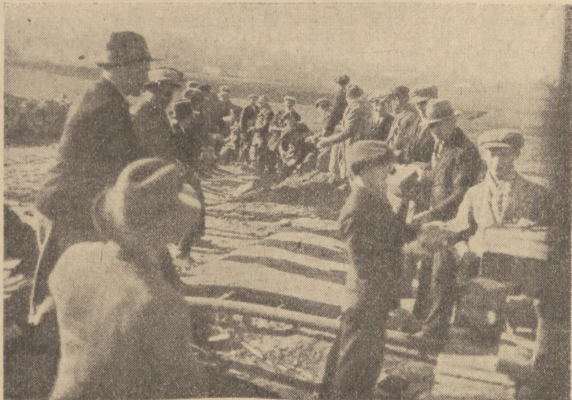
Budowa domu U. L. w Gaci 1935—36 r.
