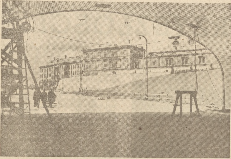
Widok na Hipotekę z wylotu tunelu na parę dni przed otwarciem Trasy W—Z. Fot. Dąbrowiecki
