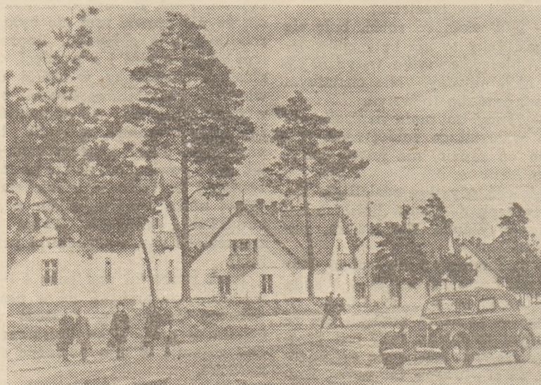
W takich domkach mieszkają pracownicy Zakładów Samochodowych w Mińsku.
