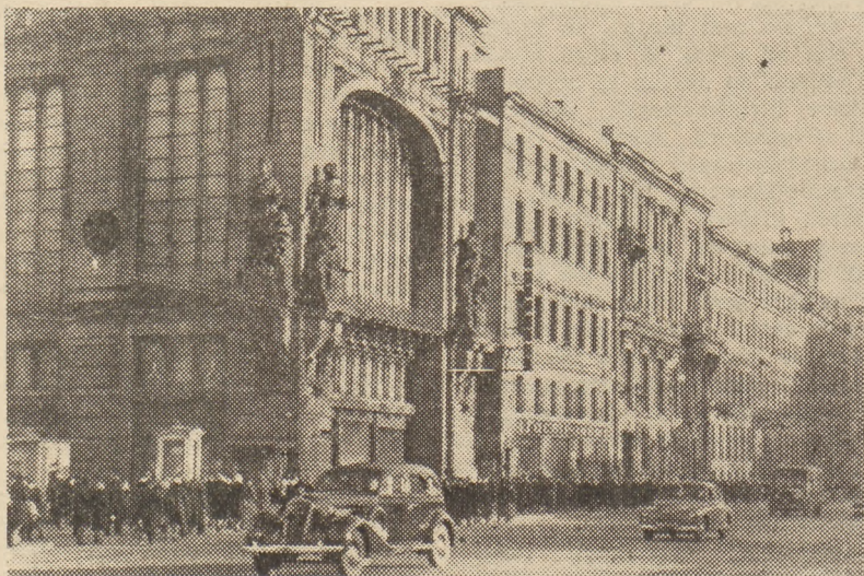
Reprezentacyjny hotel stolicy ZSRR.—Hotel „Moskwa“, zbudowany według projektu architekta Szczusiewa.
