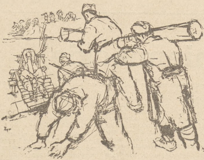
Budowa mostu na Neretwie
