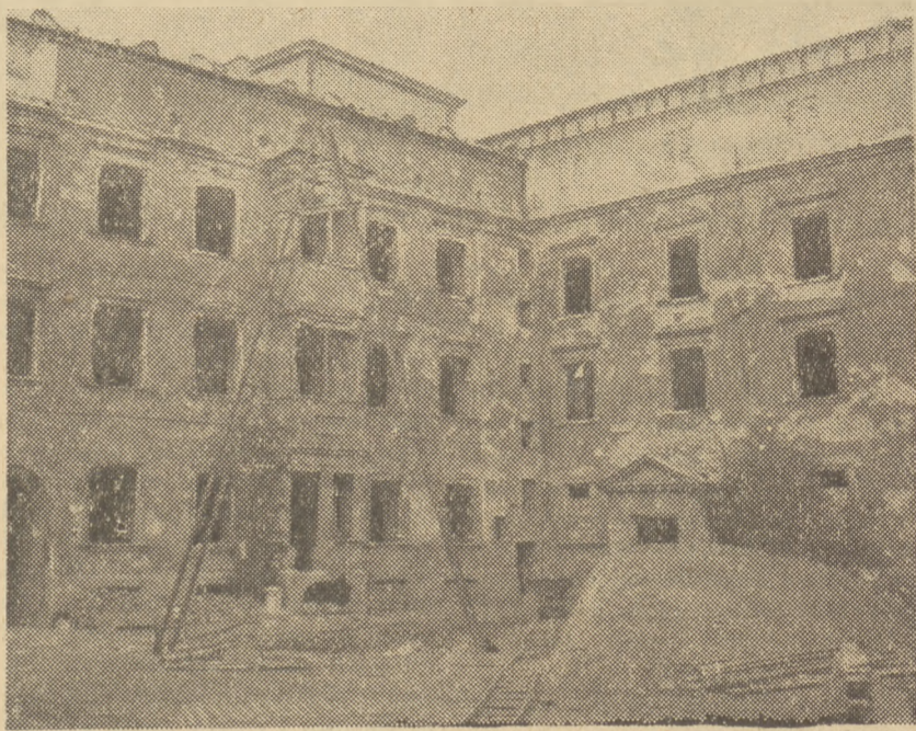
WYKOPALISKA NA ZAMKU W SZCZECINIE
