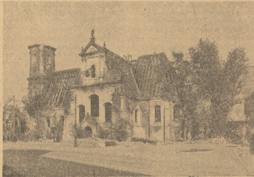
Kościół św. Maurycego we Wrocławiu w czasie remontu
