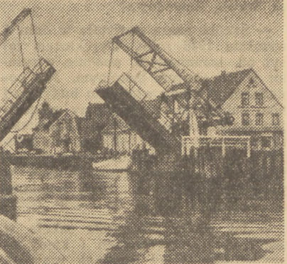
Zwodzony most przy wejściu do portu w Darłowie
