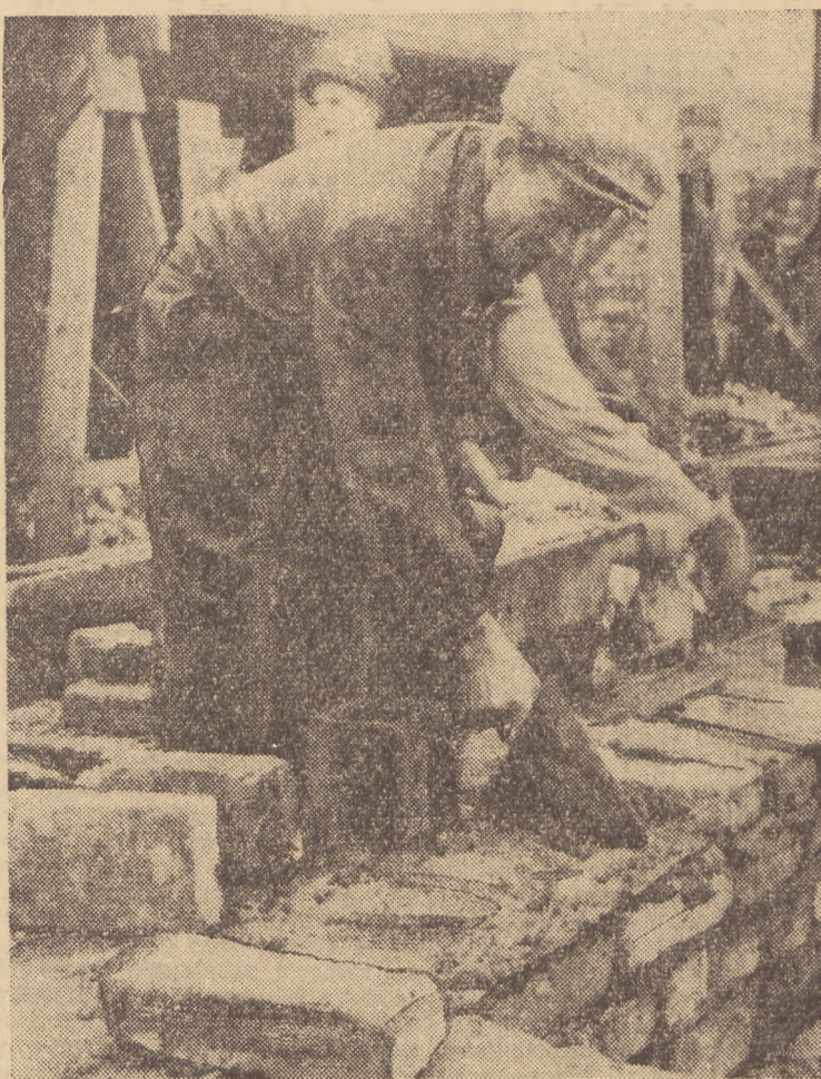
Michał Krajewski, to pierwszy dziś murarz w Polsce. Zainicjował on słynny już system „trójek” murarskich, gdzie jeden murarz i dwaj pomocnicy wykonują niemal trzykrotnie więcej, niż trzech nieorganizowanych murarzy. Dwa dni temu otrzymał on w darze od Min. Odbudowy pełny komplet fachowych wydawnictw budowlanych. (Fot. API)
