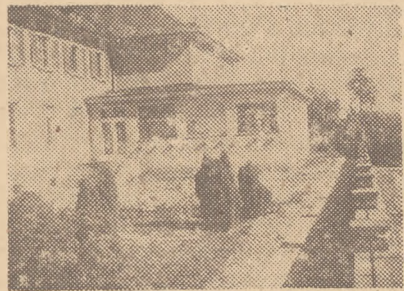
Dom Społeczny PZZ w Krośnicach nad Odrą Widok od strony ogrodu
