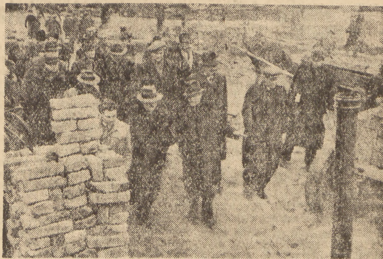
W dniu wczorajszym Min. Przemysłu i Handlu H. Minc w towarzystwie prezesa Spółdzielni Wydawniczej „Czytelnik“ J. Borejszy, dokonał przeglądu prac na terenie budowy „Domu Słowa Polskiego“.
