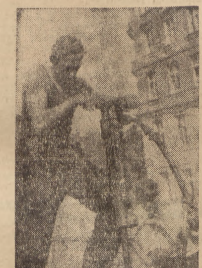
Przy pracy nad odbudową
