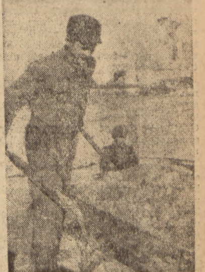
Przy pracy nad odbudową
