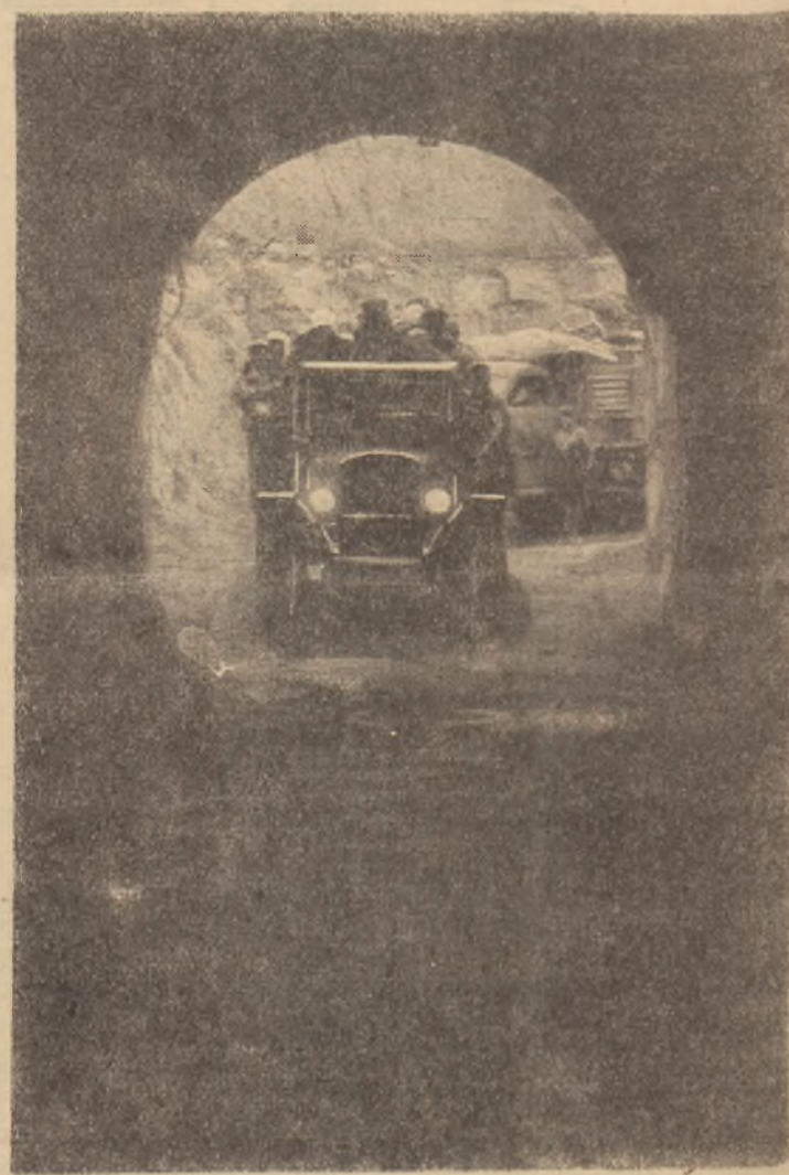
W czasie trwania prac nad odbudową Dnieprostroju, komunikacja oraz transport materiałów budowlanych z jednego brzegu Dniepru na drugi odbywały się przez tunel, ciągnący się przez masę zapory.
