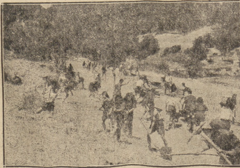
Ochotnicza Brygada Pracy młodzieży bułgarskiej przy budowie szosy przez góry Balkan
