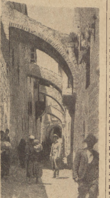
Charakterystyczna część Drogi Krzyżowej, z lukowymi podporami, zabezpieczającymi mury przed skut- kami trzęsienia ziemi.
