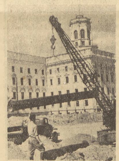
Przy odbudowie ulicy Radzieckiej zatrudnieni są ludzie wszelkich zawodów oraz dziesiątki maszyn. Pod chodnikami ułożonych zostało ponad 600 m nowych rur wodociągowych i taka sama ilość kanalizacyjnych. Na zdjęciu: zakładanie rur kanalizacyjnych na ulicy Radzieckiej
