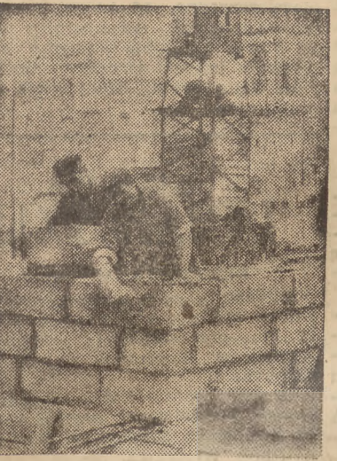
Robotnicy przy budowie gmachu Min. Przemysłu i Handlu
