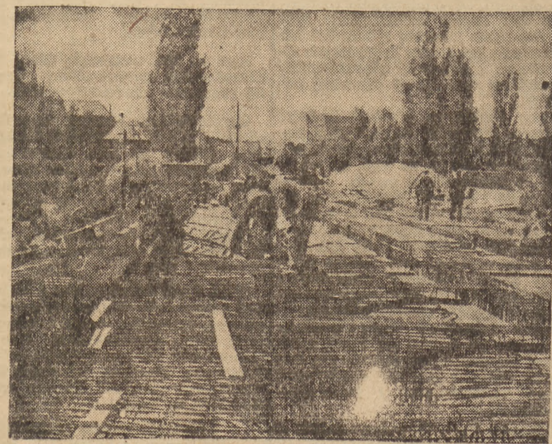
„Zbrojarze” przy pracy na Moście Akademickim w Szczecinie
