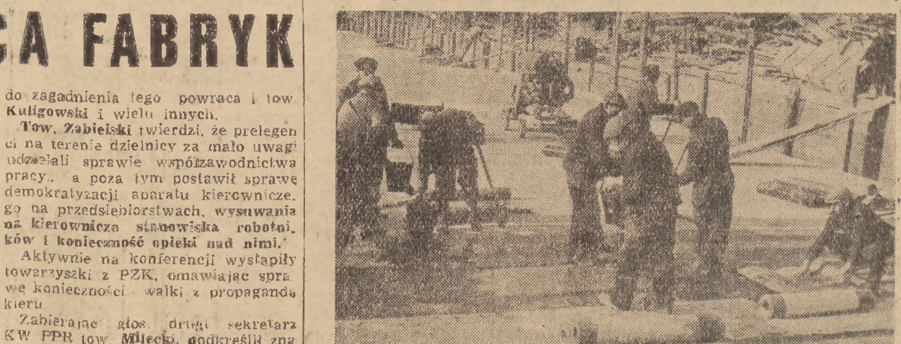
Praca przy budowie tunelu linii średnicowej przebiega zgodnie z przyjętym ziołowianianym przedkrogiem esowym. W ciągu ostatnich paru dni na stop tunelu położono warstwy bituminy i lepu, a ponadto warstwy cementu. Do dn. 15.XII br. odcinek jazdy od Nowego Świata do ul. Brackiej będzie oddany do użytku.
