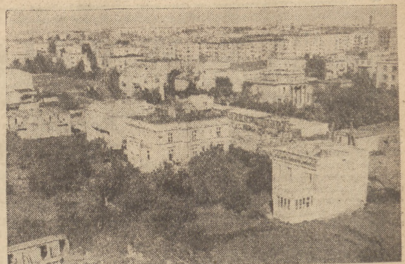
Na Mokotowie powstaje nowe osiedle mieszkaniowe WSM. Oto widok nowych budynków wzdłuż z lotu ptaka. Roboty budowlane prowadzi SPB.
