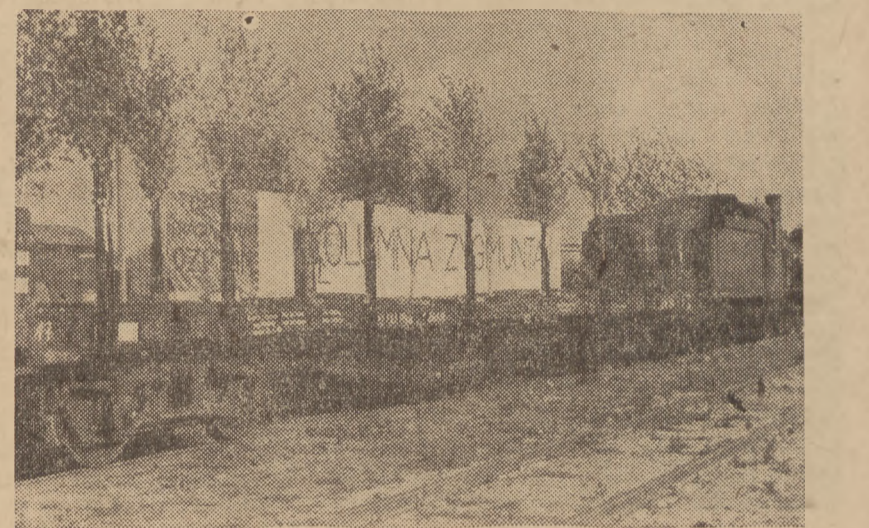
Na fotografii u góry cokol Kolumny Zygmunta po wyładowaniu z wagonu i na fotografii dolnej — cokol na wagonie.
