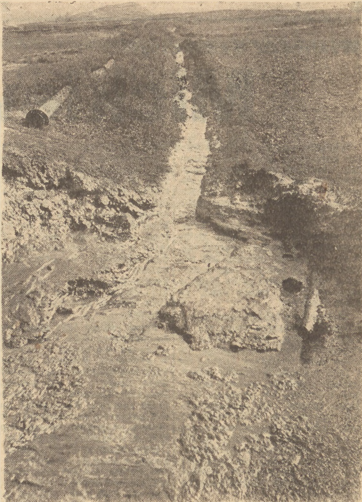
„Rawit“ w stanie jeszcze płynnym. Muł ten po wyschnięciu, stanowi wartościowy produkt eksportowy, używany przez gazownie do czyszczenia gazu świetlnego
