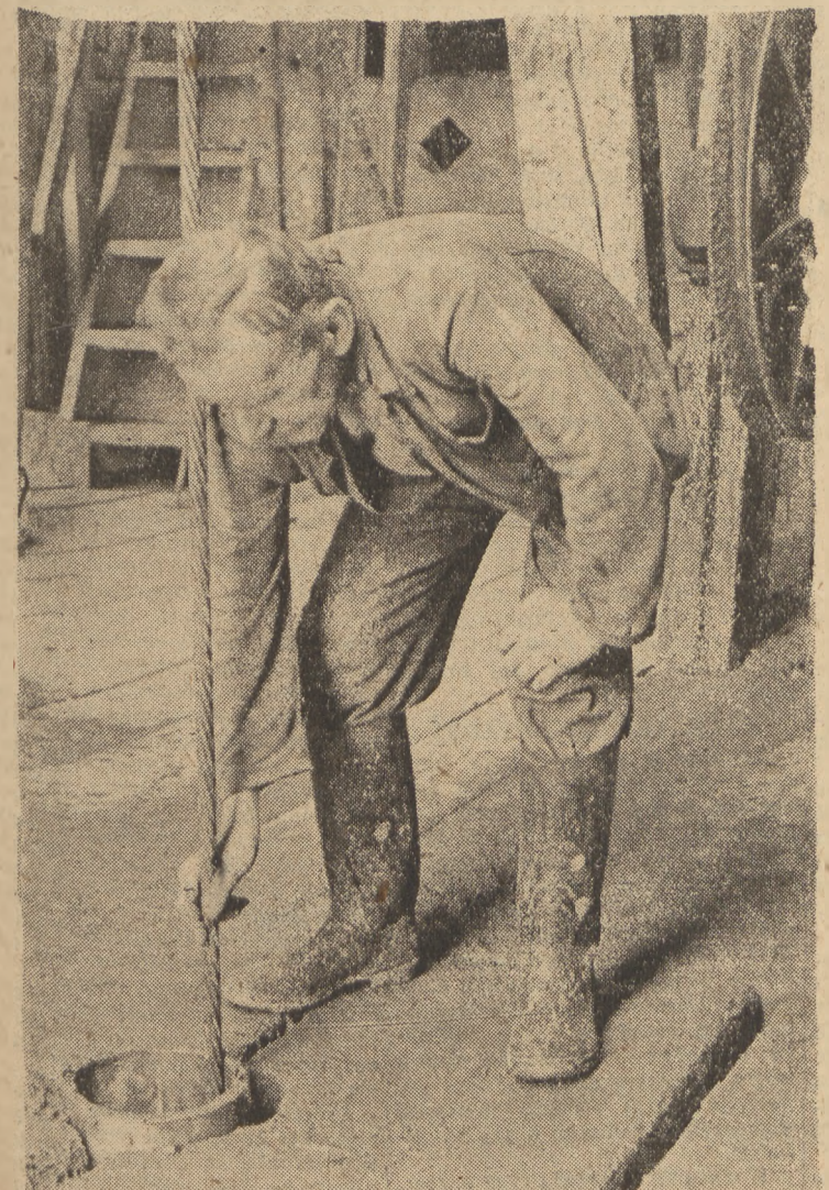
Wierzy dotychczasowy wiertacz na szybie „Dębowiec III”, właśnie bawący na wszystko, przy spuszczeniu liny ze świdrem w głąb otworu wieźniaczego
