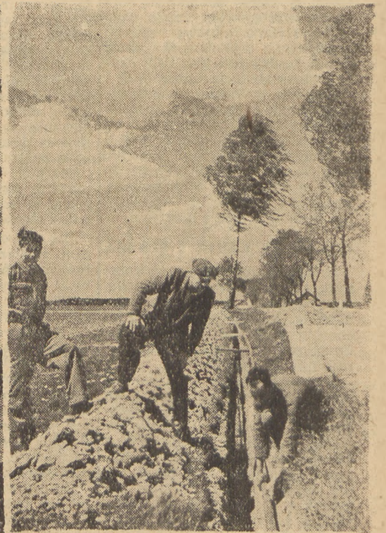
Przygotowanie rowu na nowy rurowciąg gazowy
