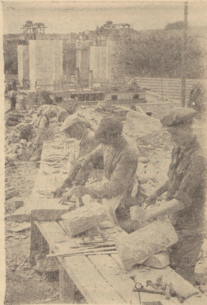
Kamieniarze pracują w pocie czoła, wykuwając głazy na budowę gigantycznej podstawy pomnika
