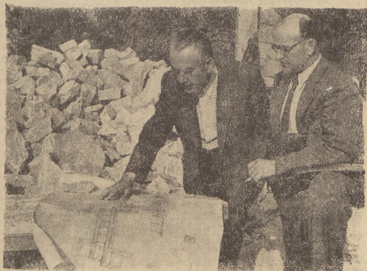
Kierownicy budowy inż. Jan Korduła i Ochman omawiają szczegóły prac
