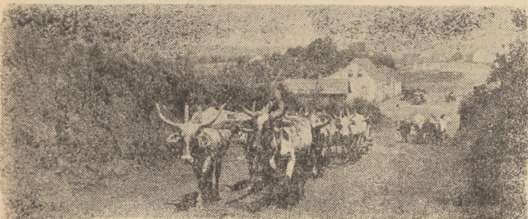
Widok powstającego osiedla w Argentynie
