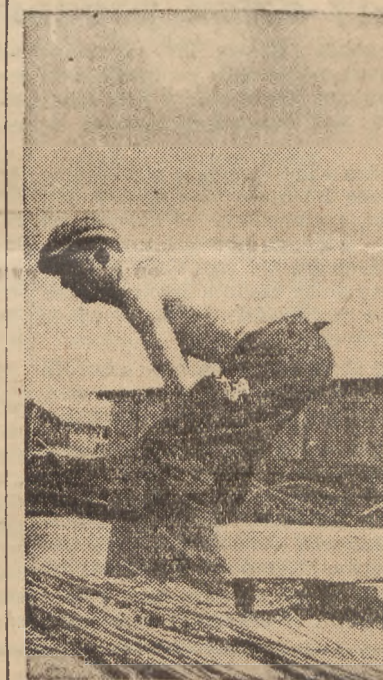
Rosną olbrzymie, jasne bloki mieszkalne na nowobudowanej kolonii WSM w Mokotowie. Bloki te pomieszczą 10.000 mieszkańców (w słońcu 6.000 lokatorów musi opuścić zagrożone lokale). Domy będą masywne — to nie nleżą wątpliwości. Na zdjęciu jeden z robotników sortuje stalowe pręty do żelazo-betonowej konstrukcji.
