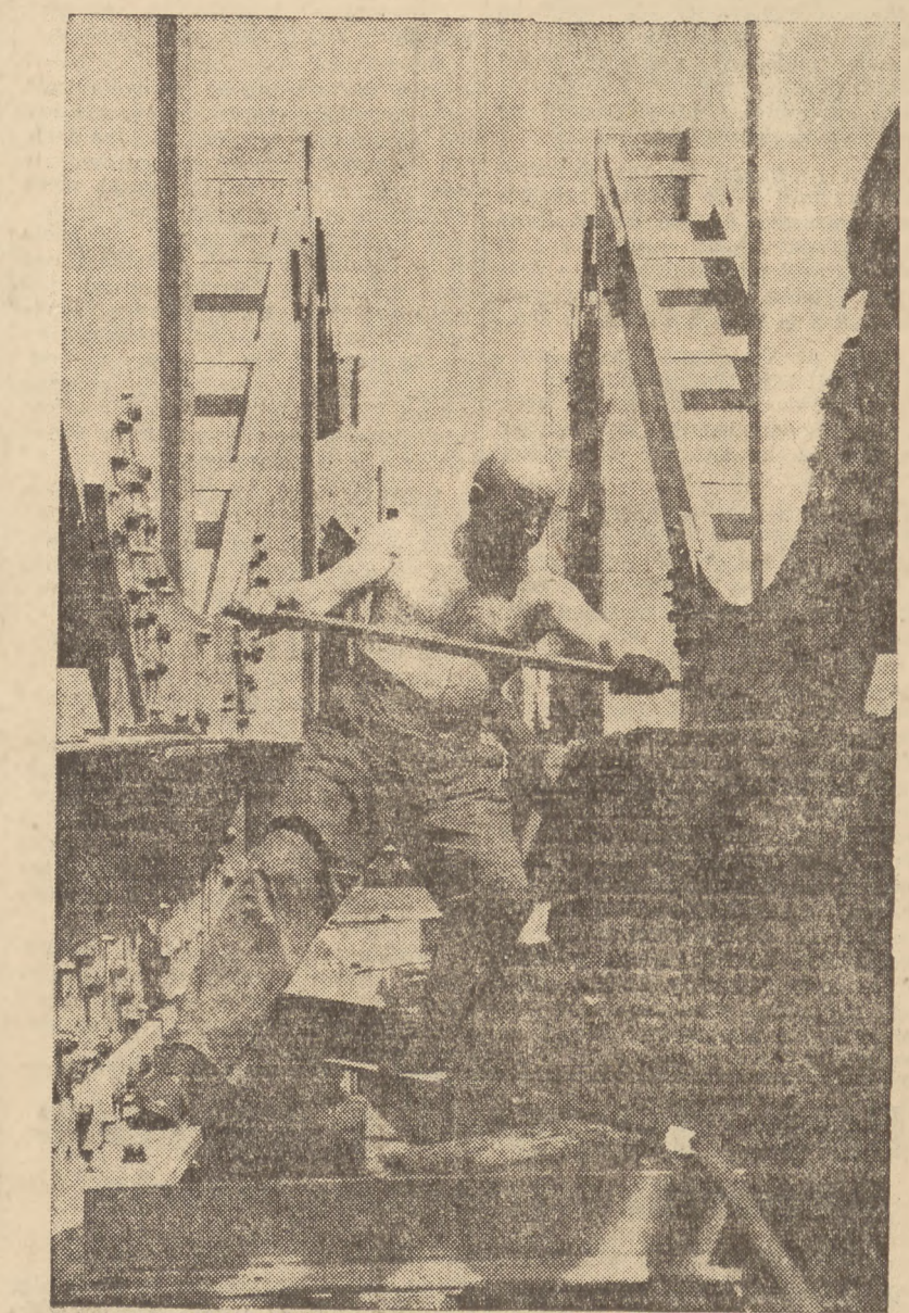
Jedną z najszybciej postępujących prac przy odbudowie stolicy jest zakadanie żelaznej konstrukcji przęsła mostu kolejowego linii średnicowej na Wiśle. Most ten zniszczony podczas działań wojennych, niegdyś dwutorowy, obecnie odbudowuje się, jako most o czterech torach. Założono już dwa przęsła, trzecie jest w stadium montażu. Na zdjęciu fragment mostu — praca przy budowie trzeciego przęsła; mechanik Sitawek dodaje śruby.
