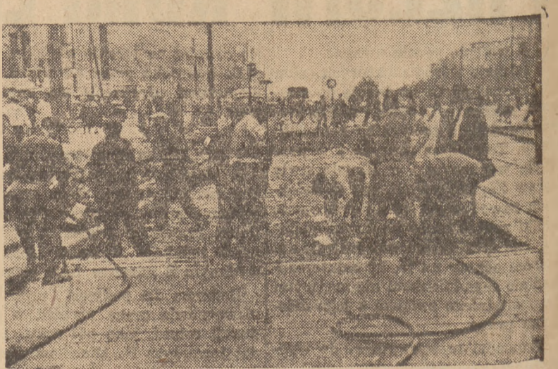
Wstępne prace przy poszerzaniu tunelu na odcinku Bracka - Nowy Świat. Zrywanie jezdnii przy pomocy młotów pneumatycznych.
