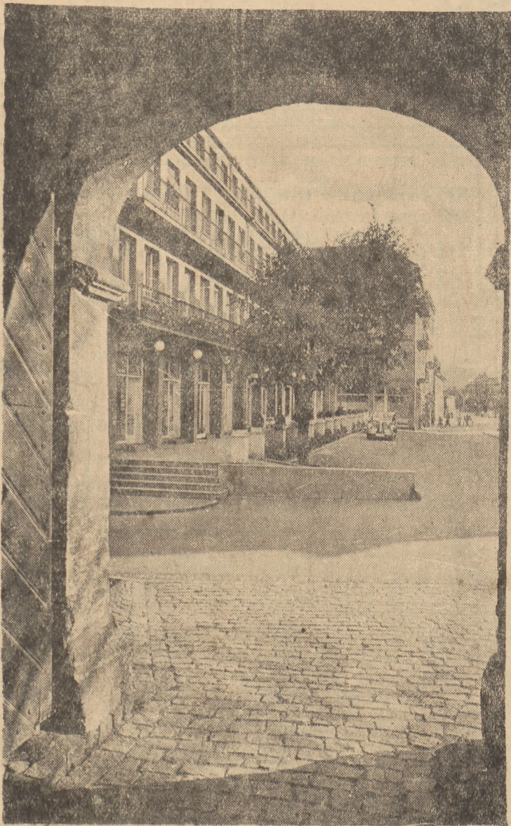
Dom Zdrojowy w Cieplicach od strony starej wieży kościelnej. Foto „Dziennik Zachodni“
