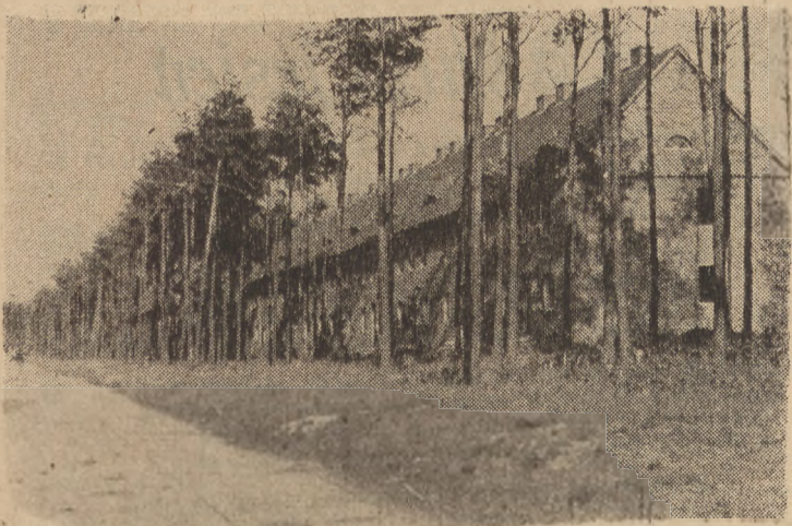
Wśród lasów sosnowych ciągnie się nowoczesne biuro w których są mieszkalni górnicy.
