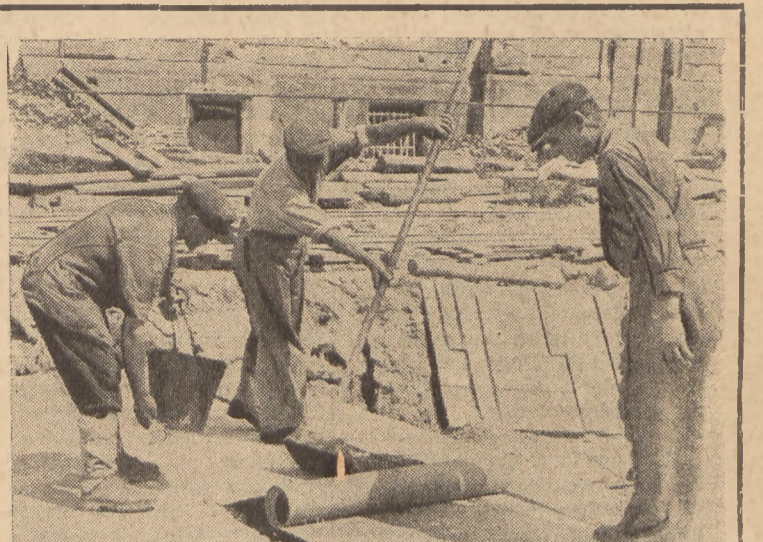
Budowa tunelu linii średnicowej w Warszawie postępuje szybko naprzód. Na zdjęciu układanie izolacji zabezpieczającej przesianie wody. Foto SAP.
