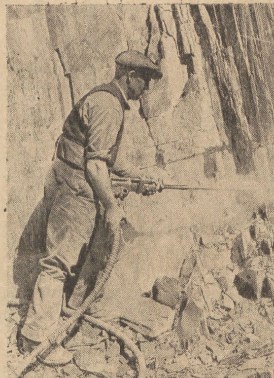
Pneumatycznym świderem drąży się otwory w masywie skalnym kamieniołomu. Ilość ładunku wybuchowego musi być tak dobrana, by eksplozja nie zniszczyła płyt łupku, a spowodowała jedynie pęknięcia w płaszczyźnie łupkowości i obalenie płyt. Foto SAP dla „Dziennika Zachodniego“
