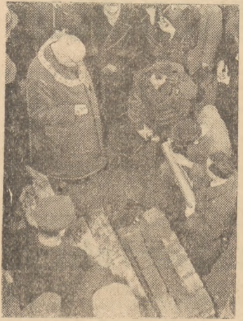
We Frankfurcie nad Menem przystąpiono do odbudowy zniszczonego kościoła św. Pawła oraz kolonii im. Fryderyka Eberta. Na zdjęciu widziemy fragment położenia kamienia węgielnego w osiedlu Fryderyka Eberta.
