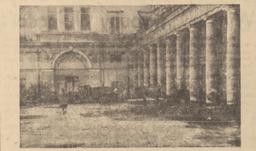
Wskazując dowiadujemy, Wydział Kwaterunkowo - Budowlany Ministerstwa Obrony Narodowej przystąpił do wykonania robót zabezpieczających i porządkowych. Obecnie wywozi się grus i popiół z wnętrza sali teatralnej. Dalsze losy Teatru Narodowego uzależnione są od decyzji odpowiednich władz wojskowych. (w. b.)
