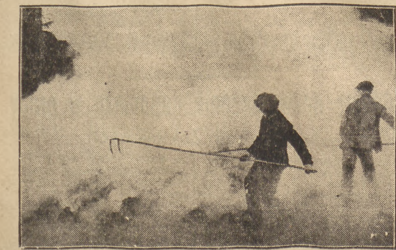
Koksownia „Wiktorja” w Wałbrzychu. Gaszenie wydobywanego z pieca koks. Robotnicy rozgrzebują koks i zalewają go wodą
