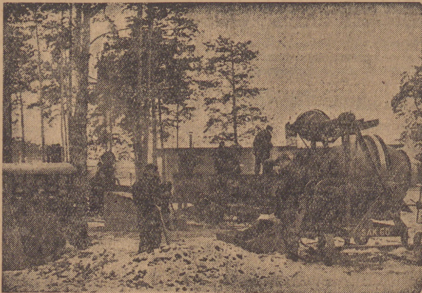
W Otwocku trwają prace nad budową szpitala dla dzieci, fundowanego przez Szwecję
