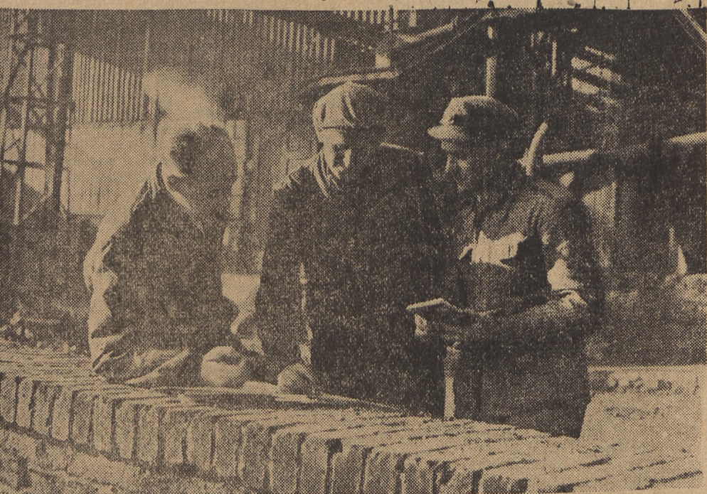
Racjonalizatorzy huty „Kościuszko“ — tow. tow. Petyk, Piotrowski i Szabasta wprowadzają nowe urządzenia. Ostatnio zainstalowali przy przebudowie palenisk 445.800 zł. Poza tym, przez zwiększenie komory spalania, usprawnili działanie kotłowni — co przynosi rocznie dodatkowe oszczędności w sumie 1.200.145 zł. Nowym pomysłem trójki racjonalizatorskiej jest projekt przebudowy palenisk kotłowni systemu blokowego.
