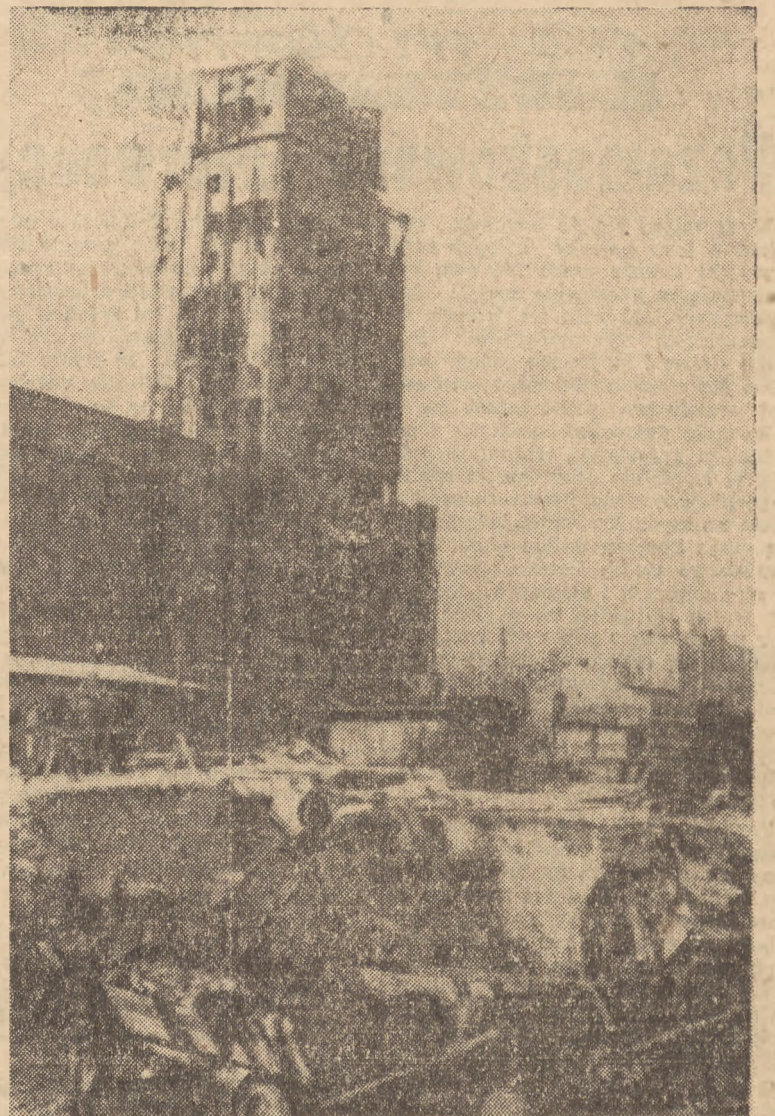
Naprzeciw warszawskiego „drapacza chmur” na Pl. Napoleona rozpoczęto kopanie fundamentów pod rozległy gmach biurowy Narodowego Banku Polskiego, który za cztery lata będzie centralnym punktem powstającego teraz „city” bankowego stolicy.
