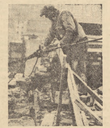
Prace przy konstrukcji dachu żelbetonowego
