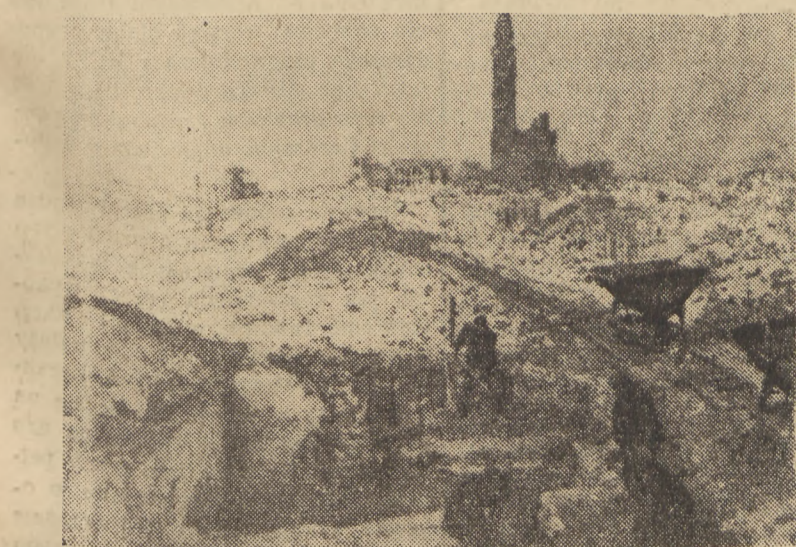
W północnej dzielnicy Warszawy rozpoczęto już wstępne prace niwelacyjne. Gdzie w najbliższej przyszłości powstanie nowe osiedle mieszkaniowe. Na zdjęciu widok robót na odcinku ul. Leszno — Dzielna.
