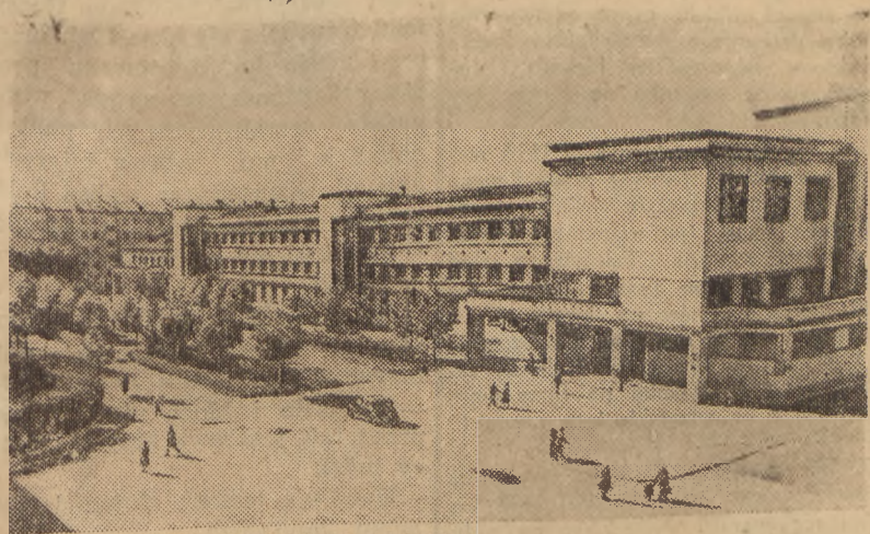
Leningrad, poważnie zniszczony w czasie działań wojennych powraca obecnie do dawnej świetności. Odbudowano m. inn. szereg szpitali i klini- ków. Na zdjęciu nowoobudowany gmach polikliniki w dzelnicy robotni- czej Leningradu
