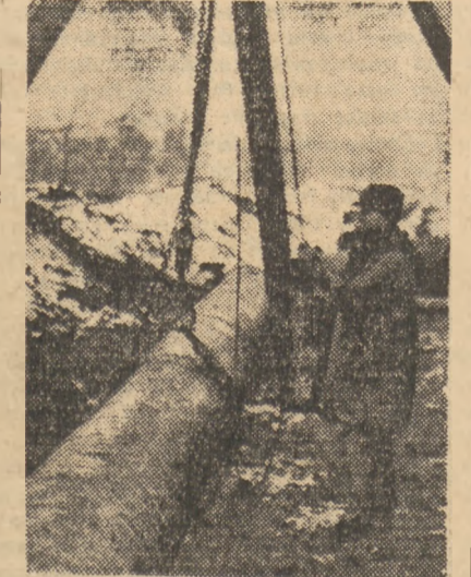
Coraz więcej nowych przewodów gazowych układa się pod ulicami miasta.
