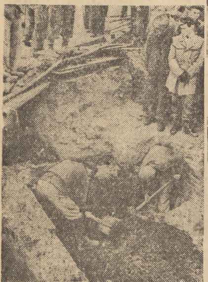
Prace przy rozkopywaniu fundamentów dawnego klasztoru Bernardynek. Tutaj przypadkowo odkryto podziemne przejście do Zamku.
