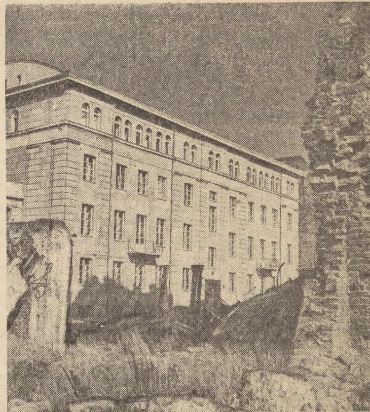
Wśród ruin Bielańskiej, na tyłach zniszczonego Banku Polskiego bieleje jasna plama pięknie odnowionego domu przy rogu Daniłowiczowskiej. Chwilowo mieszczą się tu biura Nar. Banku Polskiego. — Gdy stanie wielki gmach bankowy na Pl. Napoleona — tutaj zamieszkają pracownicy NBP. (Fot. APD)
