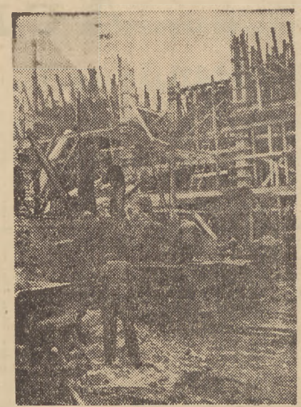
W okresie 11 miesięcy zdołano nie tylko usunąć gruzu stojących tu dawniej domów, wyrównać teren i wykopąć dół pod fundamenty, ale również dźwignąć do wysokości 8 kondygnacji zachodni budynek.
