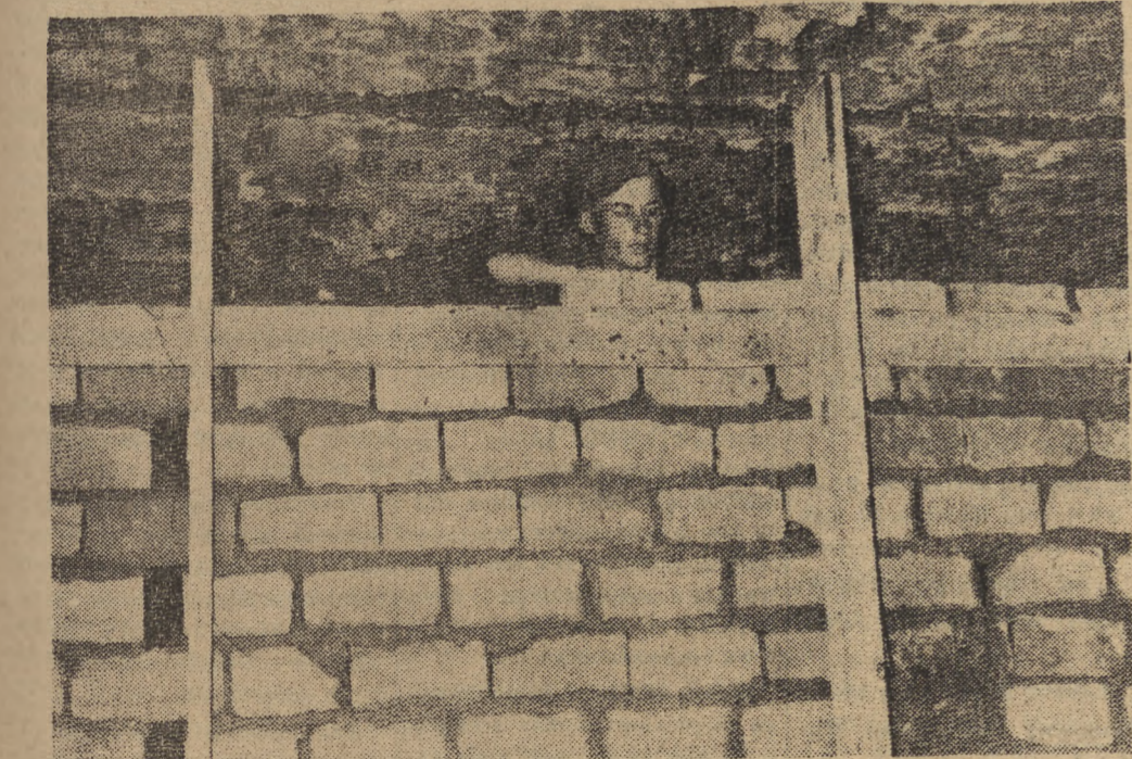
Robotnicy Rożyk i Olak zatrudnieni przy budowie osiedla robotniczego Muranów B skonstruowali przyrząd ułatwiający budowę ścian działowych. Zamiast wycieczki pionowo deski między podłoga a sufitem, do których drutami przymocowana jest deska pozioma. Przy pomocy tego urządzenia pomocnik murarski może w ciągu chwili wymurować 60 m kw., podczas gdy starym systemem nawet wykwalifikowany murarz wymurował tylko 30 m kw.
