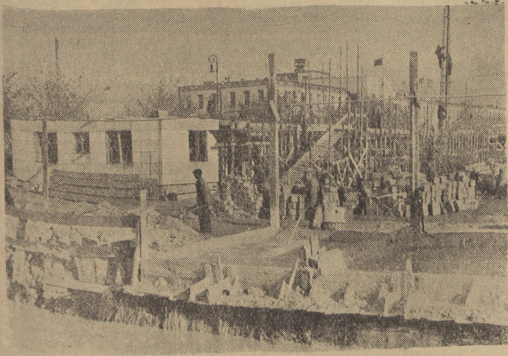
Najmłodsze z warszawskich osiedli ZOR powstaje na Pradze przy ul. Ratuszowej. Domy jego budowane są z elementów prefabrykowanych z gruzu. Foto AR
