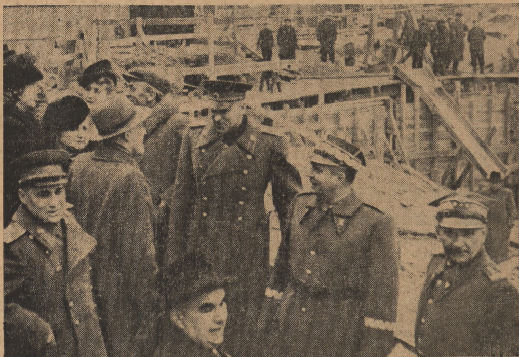
Marszałek Rokossowski ogląda w towarzystwie Marszałka Żymierskiego, gen. Korczyca i prez. Tolwińskie prace przy budowie trasy W — Z
