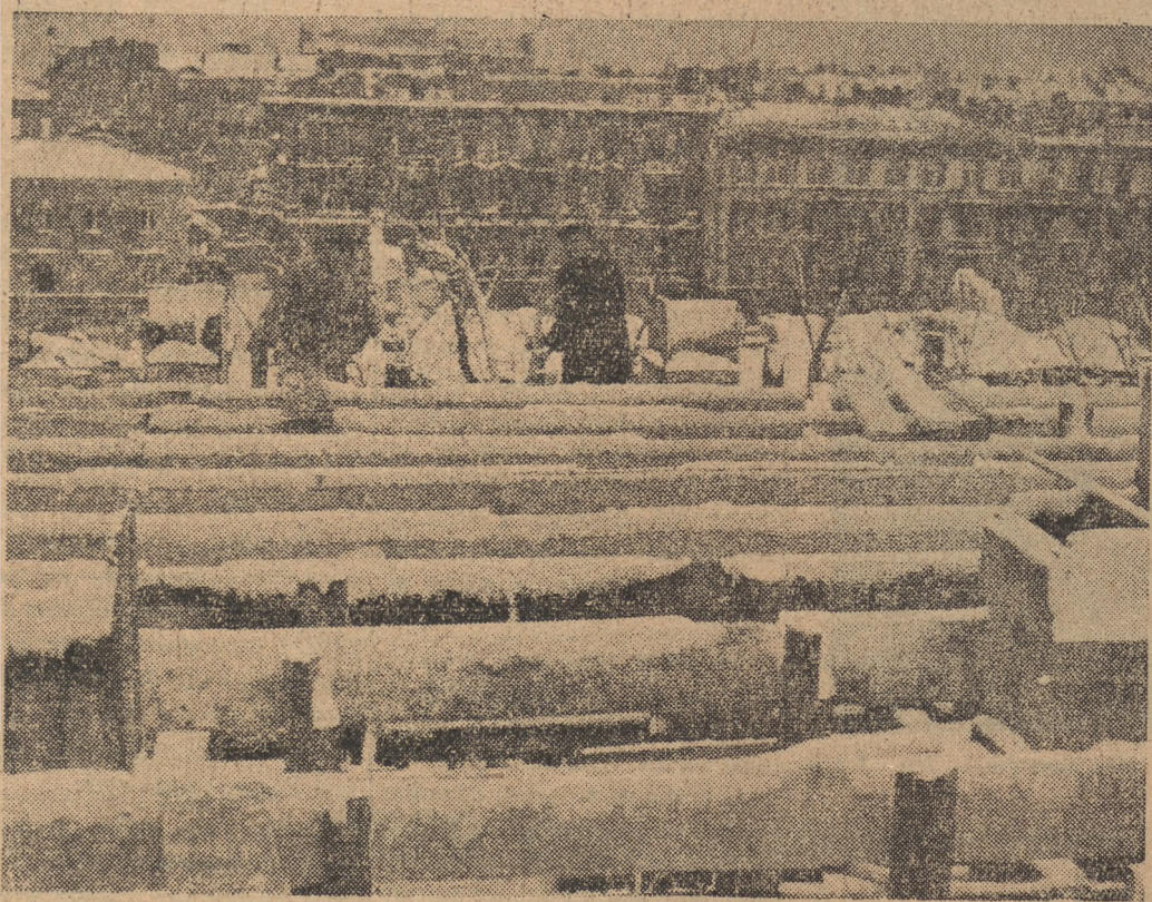
Mimo zawiści śnieżnej pracy przy budowie Centralnego Domu PZPR nie ustają. Na fotografii robotnicy zatrudnieni przy szalowaniu stropu piątego piętra.
