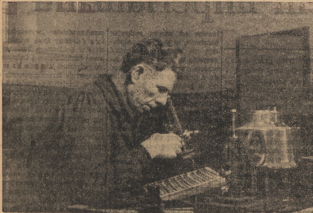
Mechanik Władysław Sętkiewicz zorganizował w Państwowych Zakładach Sztucznego Jedwabiu w Chodakowie produkcję części wymiennych do maszyn, produkujących sztuczny jedwab. Części tych nie można było nabyć na rynku krajowym. Dzięki więc pomysłowej inicjatywie robotnika — maszyny pracują normalnie, a fabryka chodakowska oszczędza poważne sumy, gdyż nie potrzebuje importować z zagranicy drogich części do maszyn
