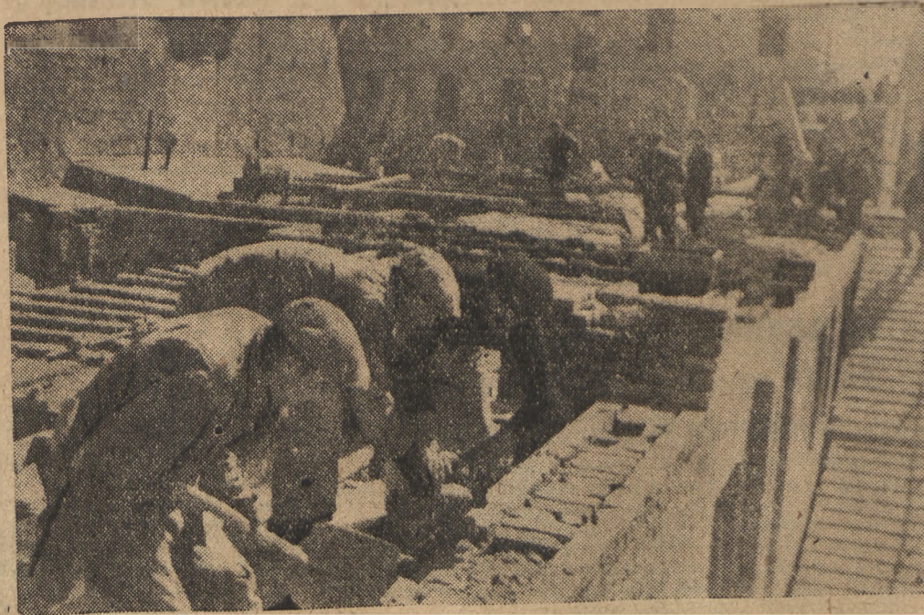
Szybko rosną nowe osiedla robotnicze w Warszawie. W osiedlu na Mirowie murarze, pracując systemem trójkowym, niedługo ukończą budowę nowych domów mieszkalnych.
